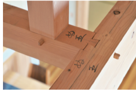
■ 木組みに残された墨付けの跡
