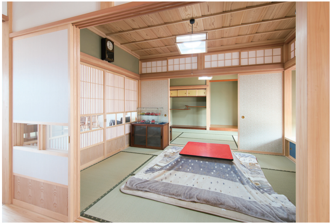
昭和レトロなたたずまいの家。二間続きの和室は施主の要望で映画「男はつらいよ」の寅さんの家をモチーフに、造作建具やふすま紙にまでこだわった。奥の床の間は床脇に違い棚を設け、一般的な配列とは反対の「逆床」となっている。
